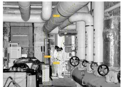
기계실의 포인트 클라우드 데이터 사진과 유사하지만 이 이미지의 각 포인트는 3차원(3D) 좌표값입니다. SCENE 소프트웨어를 사용하면 사용자는 해당 부분의 정확한 치수를 알 수 있습니다.
